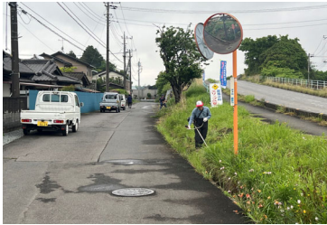
県道279号線（高速陸橋法面）
