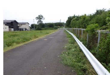
高速道路側道 作業後
