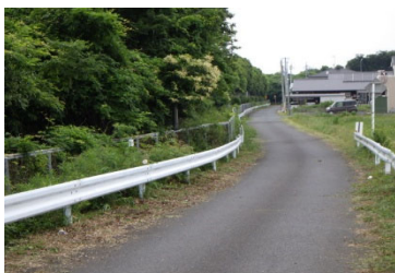
高速道路側道 作業後
