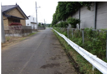
高速道路側道 作業後
