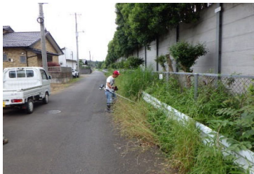
高速道路側道 作業前
